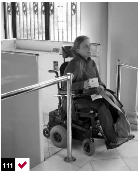
Foto 108 a 111: salvaescalera que desaparece bajo el piso para no estorbar la ambientación original de los años 1900. Casa Rosecliff, Newport, USA
