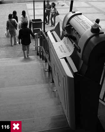
Foto 116: “salvaescalera en mantención”. Estos elementos deben estar siempre operativos para cumplir su objetivo. Temuco, Chile.
