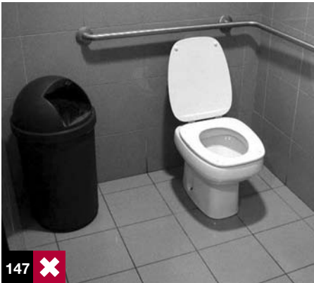
Foto 147: el basurero interfiere con el espacio determinado para la transferencia silla - inodoro. Requiere ser ubicado en otra posición.
