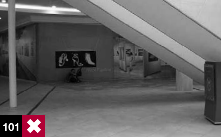
Foto 100 y 101: circulaciones bajo escaleras mecánicas con y sin protección. Puerto Montt y Santiago, Chile.
