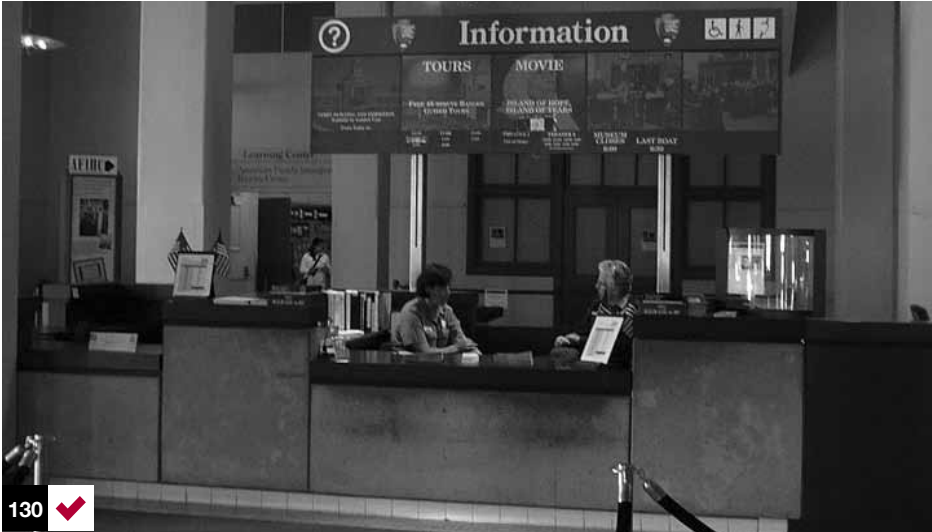
Foto 130: mesón de información y atención a público. Posee una doble altura que permite la aproximación de una silla de ruedas. Nueva York, EE.UU.
