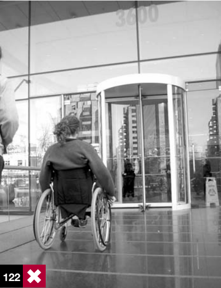
Foto 122: una puerta giratoria no se considera accesible. Debe contemplar al menos una puerta alternativa de tipo batiente. Santiago, Chile.
