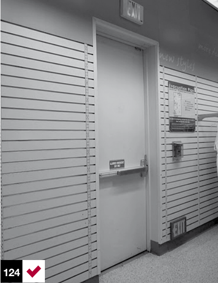
Foto 124: salida de emergencia con dispositivo antipánico, buena señalización y botón de activación de alarma de incendio a altura adecuada. San Francisco, EE.UU.
