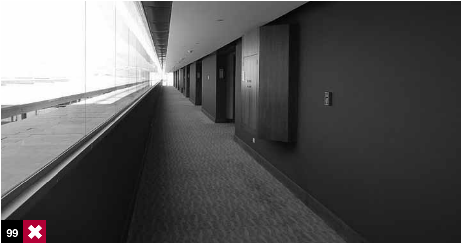
Foto 99: pasillo con elementos de seguridad sobresaliendo en recorrido. Antofagasta, Chile.
