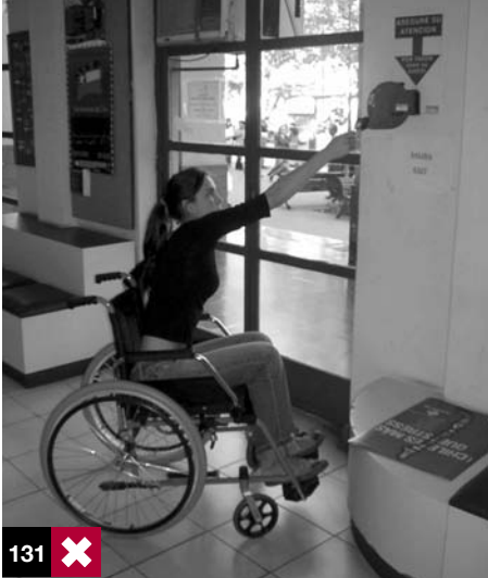
Foto 131: dispensador de ticket colocado a altura fuera del rango de alcance. Santiago, Chile.
