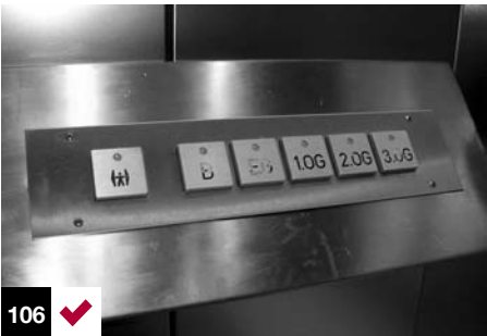
Foto 106: botonera horizontal de fácil alcance y detección.
