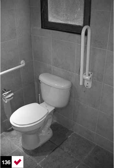
Foto 136: barra abatible que permite la transferencia y su posterior uso como apoyo.
