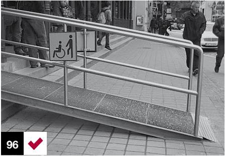
Foto 96: rampa provisoria a antigua estación de trenes indicando la necesidad de asistencia por su pendiente. Augsburg, Alemania.
