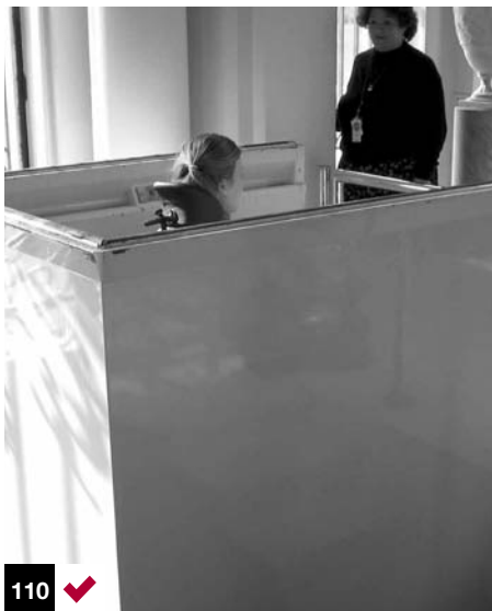
Foto 108 a 111: salvaescalera que desaparece bajo el piso para no estorbar la ambientación original de los años 1900. Casa Rosecliff, Newport, USA
