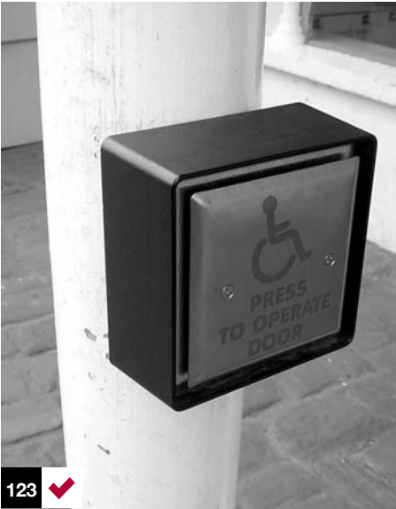
Foto 123: hay puertas de vidrio templado que son muy pesadas para abrir. Se utilizan aperturas de puertas automáticas para tal efecto. Bath, Inglaterra.
