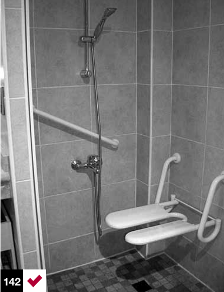
Foto 141 y 142: duchas de acceso a nivel, la solución más universal de uso.
