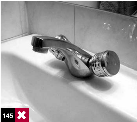
Foto 145: grifería de pomo. No se recomienda por la dificultad que presenta al accionar.
