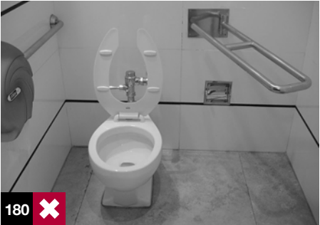
Foto 180: la incorrecta instalación de una barra abatible inutiliza el diseño accesible de este baño. Hotel en Viña del Mar, Chile.
