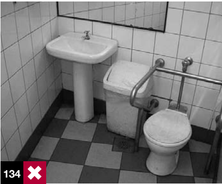
Foto 134: baño que no permite la aproximación o transferencia a los artefactos.
